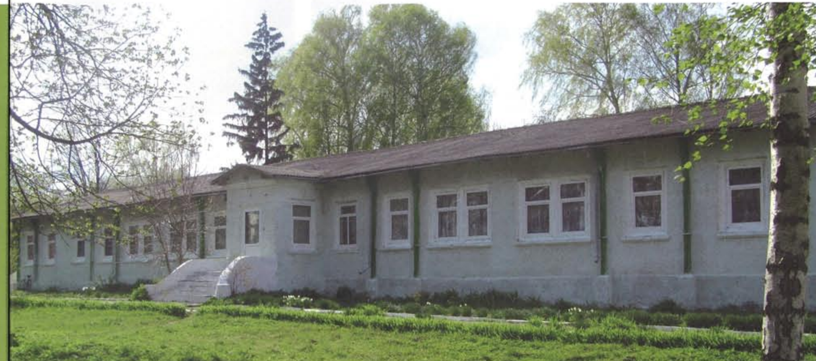
▲ Außensicht des Altenheims mit neu installierten Fenstern.
