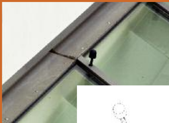
Bild 6 | So habe ich bei dieser Sanierung eine nicht zum System gehörende Entlüftungseinheit eingesetzt. Ich bin überzeugt, dass diese formal nicht ansprechende Lösung vor Ort gar nicht wahrgenommen wird.
