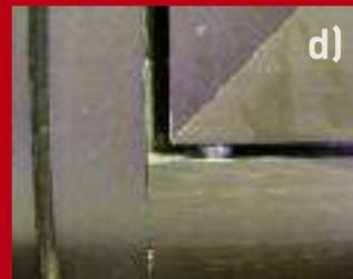
d) Die unteren Drehlager der großen Flügel sind ausgeschlagen.
