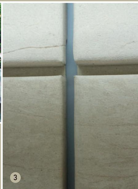
**Bild 1:** Objektaufnahme in der Montagephase: Der Eindruck ist da, wenn auch mit noch fehlenden Brüstungsplatten am Eckbereich vorn. **Bild 2:** Schlecht gedämmt, triste Anmutung: so präsentierte sich das Gebäude vor der Sanierung. **Bild 3:** Durch die Systemkonstruktion ergibt sich ein sauberes, gleichmäßiges Fugenbild in alle Richtungen.
