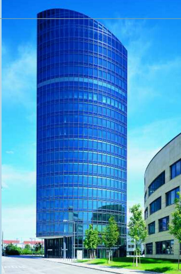
Zum Thema zunächst eine grundsätzliche Feststellung: Die Elementfassade gehört zum Oberbegriff Vorhangfassade, sie wird in voller Höhe und Breite wie eine Pfosten-Riegel-Fassade vor dem Bauwerk – Geschoßdecken und Stützen – angeordnet. Vom Konstruktionstyp her wird sie aus Pfosten-Riegel-Profilen gefertigt. Diese Einzelelemente werden dann an der Baustelle zu einer homogenen Gesamtfassade zusammengefügt.
