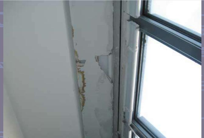
Zunächst wird der Innenbereich untersucht. Putzanschlüsse müssen aufgestemmt, Wandanschlüsse geöffnet werden. Dabei muss in Kauf genommen werden, dass solche Beschädigungen nicht zum Erfolg führen.
