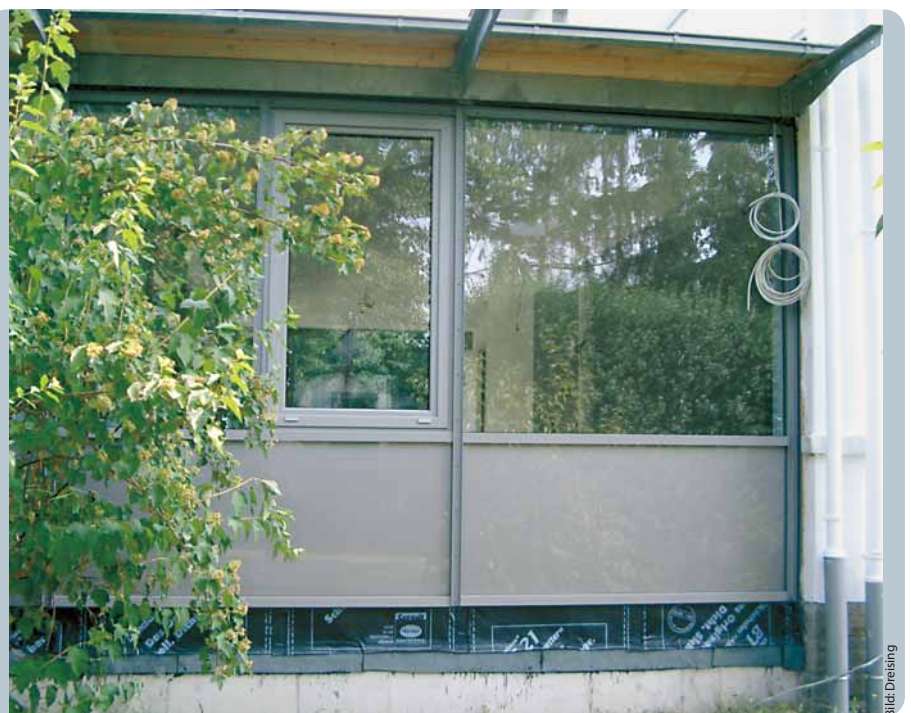
Fall 1: Alle horizontalen Deckleisten sind ohne Belüftungsspalte für die Glasfalte eingepasst worden.
