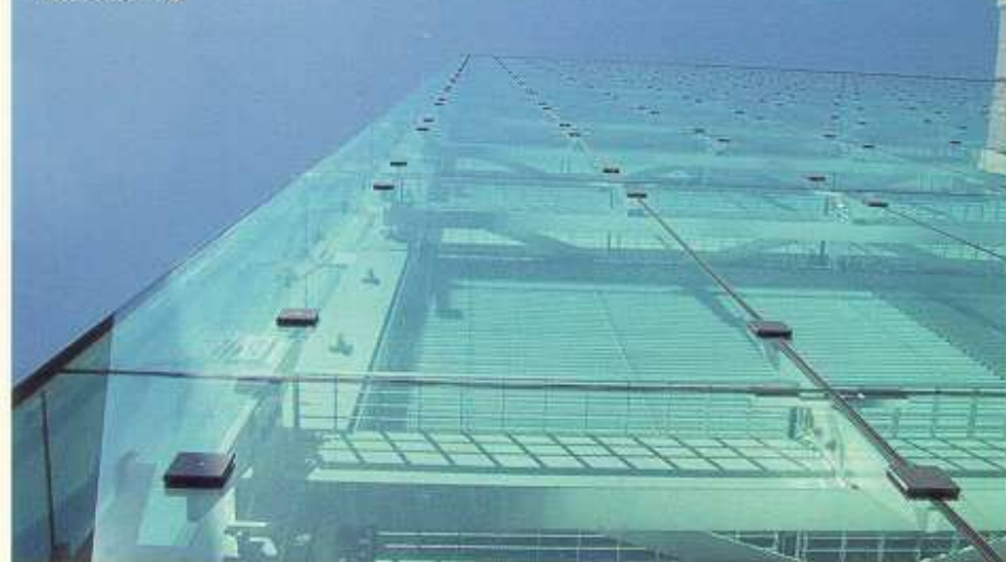
Beispiel einer punktgehaltenen Glasfassade.
