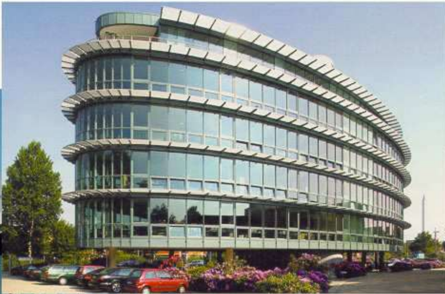
Pfosten-Riegel-Fassaden erscheinen sehr transparent und ermöglichen eine große Gestaltungsvielfalt.
